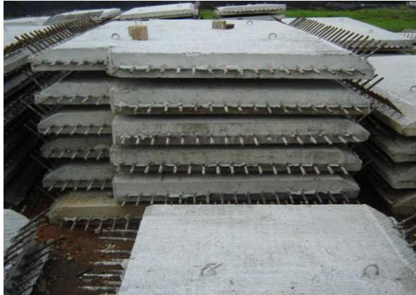
Gambar 2.9 Ilustrasi Struktur Pelat Lantai *Half-Slab*
