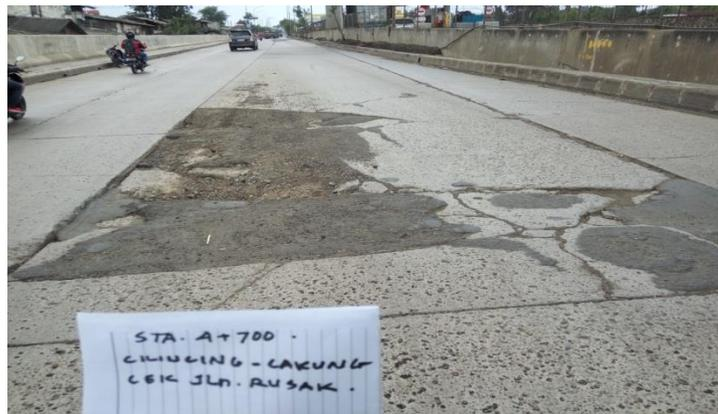
**Gambar 1.1 Kerusakan Jalan Cakung-Cilincing**
