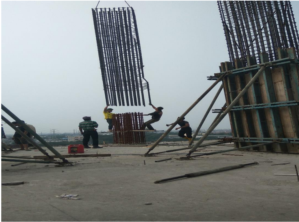
Pemasangan kolom
