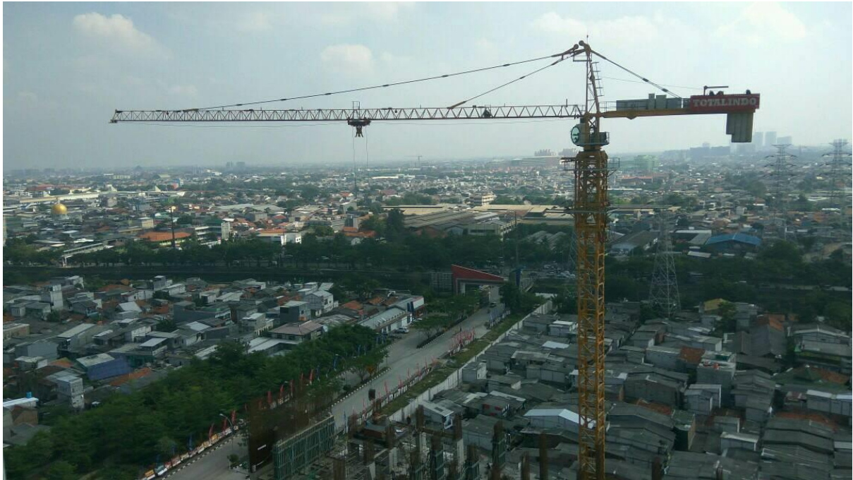
Tower Crane untuk Tower A
