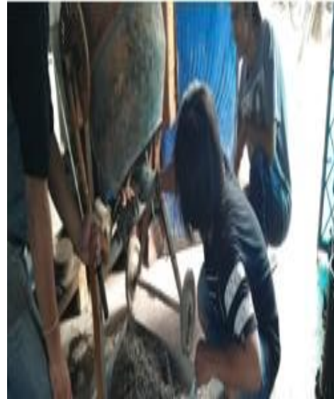
Proses Penuangan Beton
