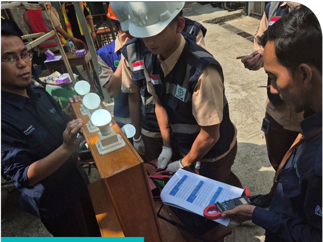
Gambar 21. Murid berhasil menginstalasi PLTS
