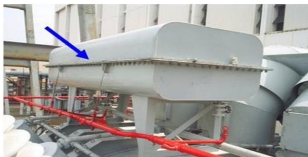
Gambar 2.6 Konservator Transformator
