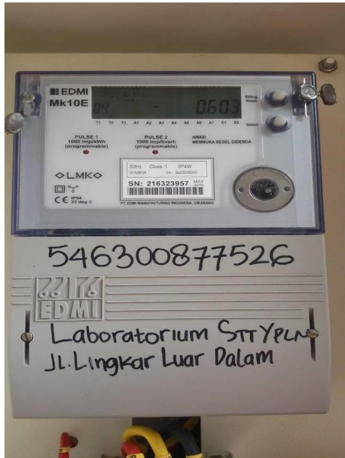
KWH meter EXIM adalah KWH meter yang digunakan untuk transaksi energi listrik (KWH) antara dua penyuplai energi, dimana KWH yang dikirim dan KWH yang diterima dicatat secara terpisah dalam KWH meter.
