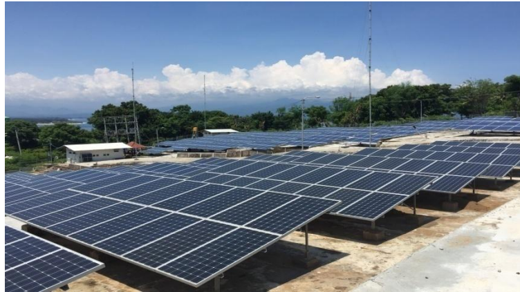
Gambar 2.30 Penyangga Modul Surya Pembangkit Listrik Tenaga Surya 400 kWp Gili Trawangan
