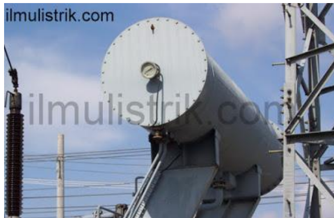
Gambar 2.6 Konservator Trafo Tenaga
