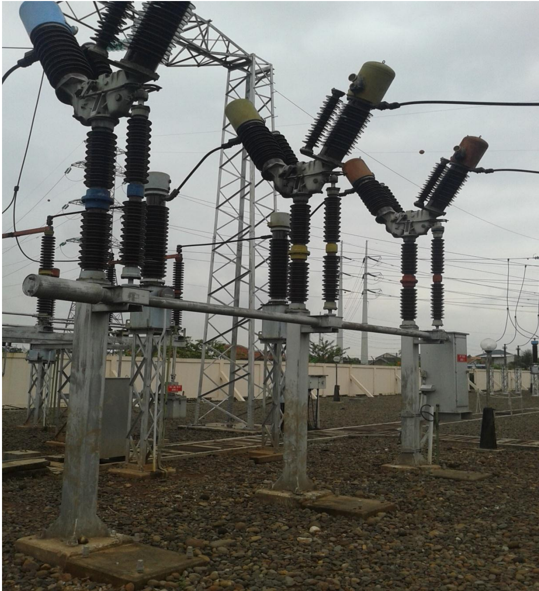
Lampiran 6. Gambar Fisik Luar PMT Minyak Tipe HLR 170/25002 B2 Three Pole.
