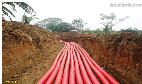
Gambar 2.7. Konstruksi Penanaman Kabel Tanah
