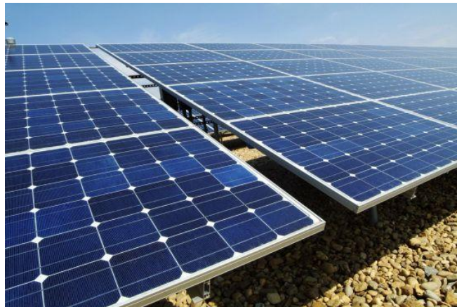
Gambar 2.7 Rangkaian Modul Surya (PV Array)
