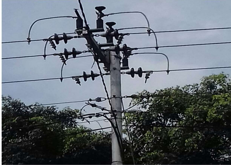
Gambar 2.8. Air Break Switchgear (ABSW).
