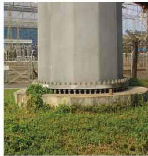
Gambar 2.13. Pondasi Steel 150 kV
