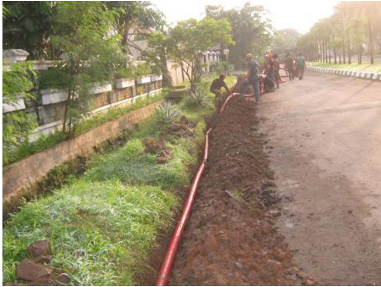
Gambar 2.4. Saluran kabel tanah tegangan menengah
