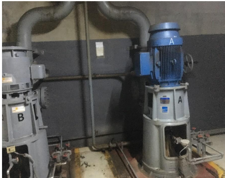
Gambar 2.1 Motor listrik di kopel dengan pompa
