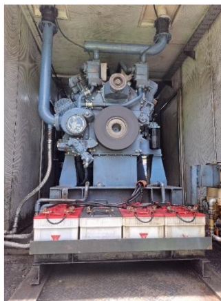
Gambar 2.2 Sistem Baterai DC PLTD Sawai Baru
