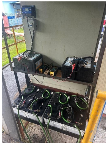
Gambar 2.5 Sistem DC Terpusat unit 7 dan unit 8
