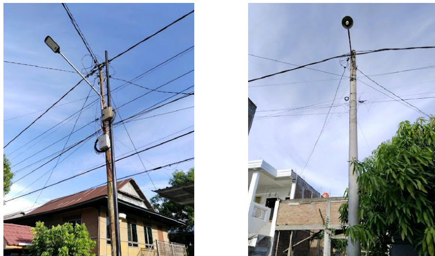
Gambar 2.5 Jaringan Tegangan Rendah (JTR)
