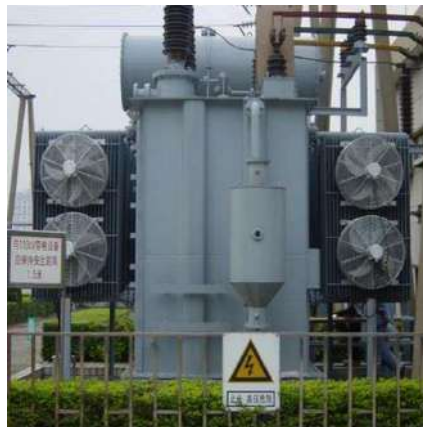
Gambar 2.15. Sistem Pendingin Kering
