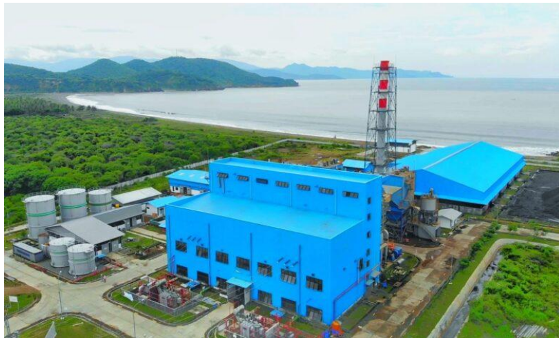
Gambar 2. 1 PLTU Batu Bara
