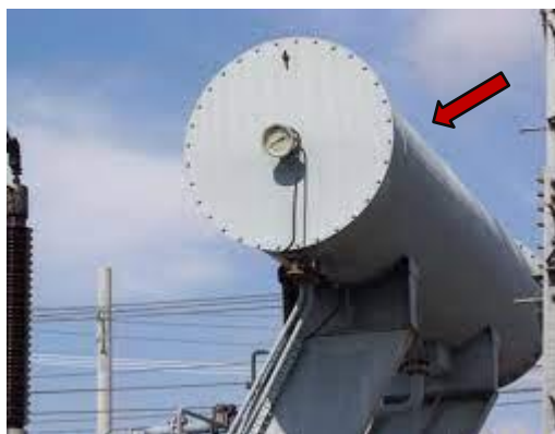
Gambar 2.6 Tangki konservator Trafo
