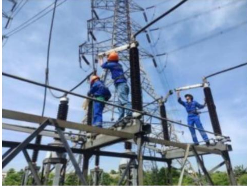
Gambar 2. 20 Perbaikan Hotspot (Multi et al., 2022)
