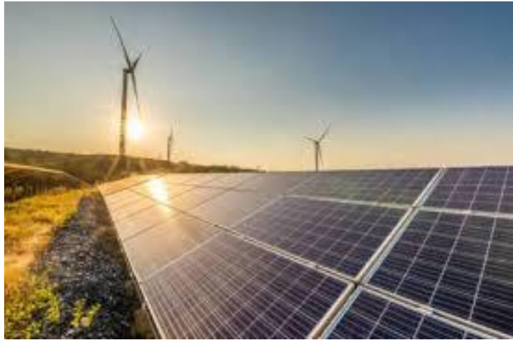
Gambar 2. 4 Pembangkit Tenaga Listrik
