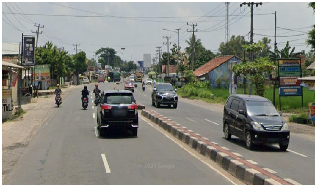
Gambar 4 18 Kondisi Akses Jalan Lalu Lintas Sumatra Menuju Lokasi
