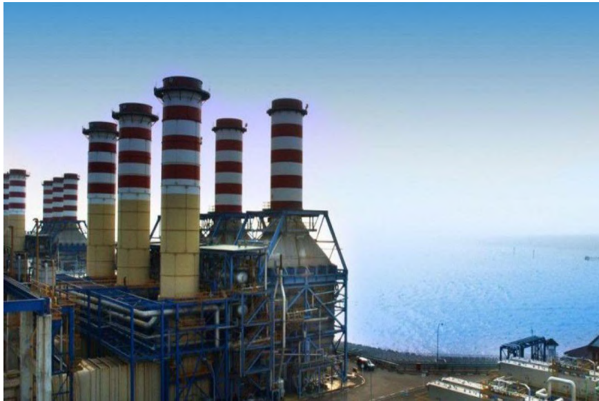
Gambar 2 3 Pembangkit Listrik Tenaga Gas
