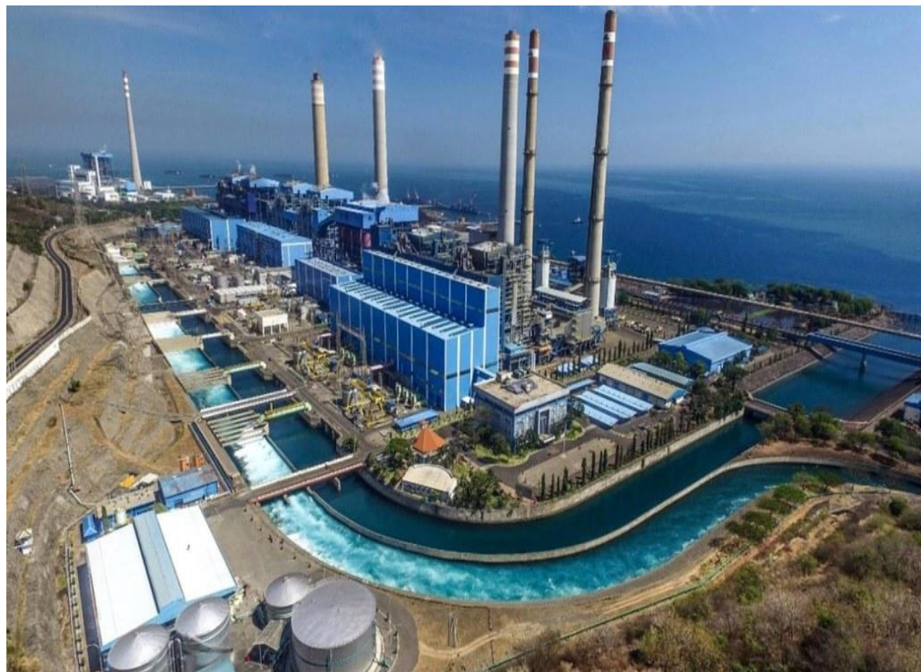
Gambar 2 2 Pembangkit Listrik Tenaga Uap
