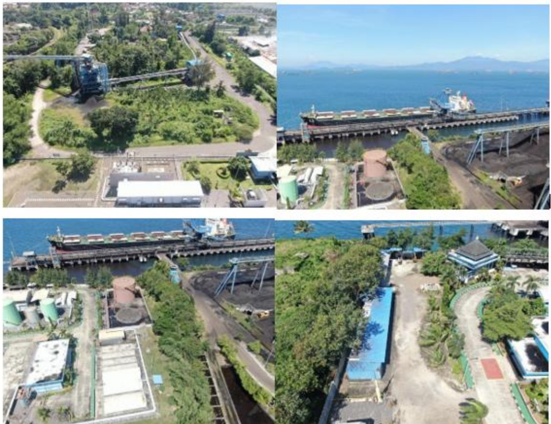
Gambar 4 4 Kondisi Area Sekitar Tarahan
