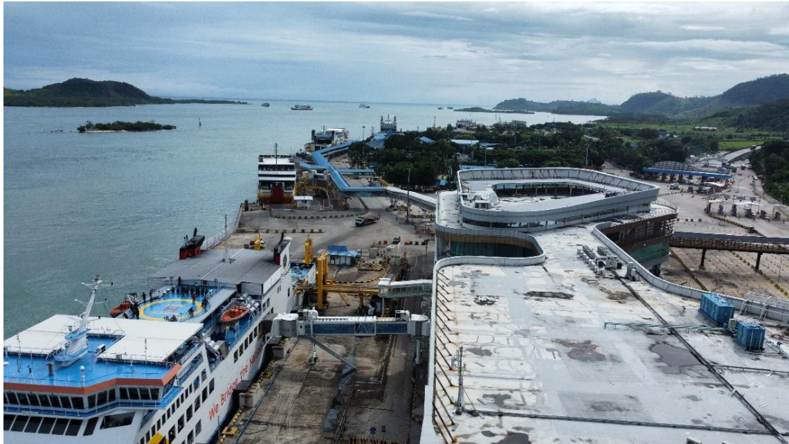
Gambar 4 22 Kondisi Pelabuhan Bakauheni ( Sebagai alternatif)(aerial view)
