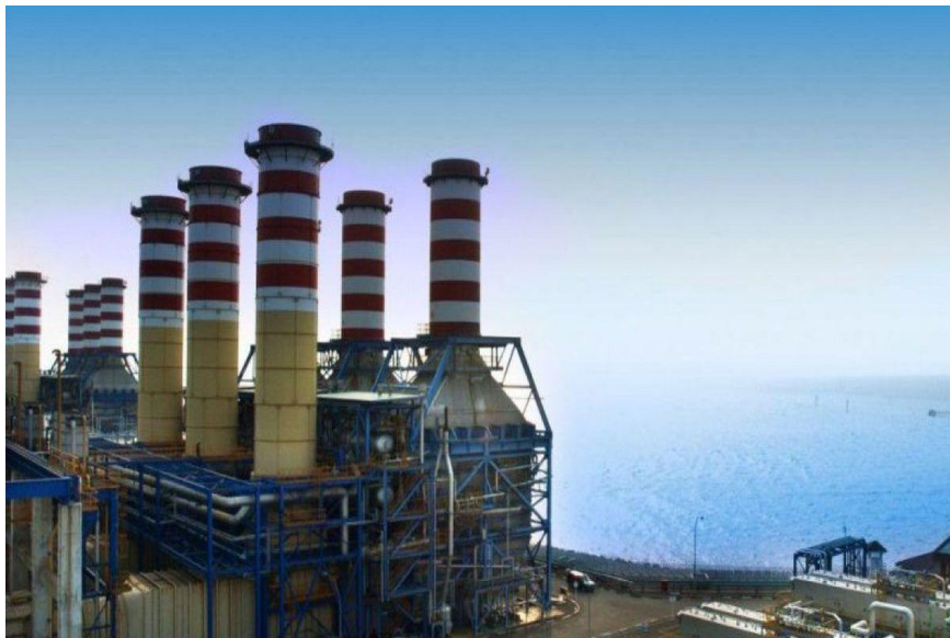
Gambar 2 3 Pembangkit Listrik Tenaga Gas
