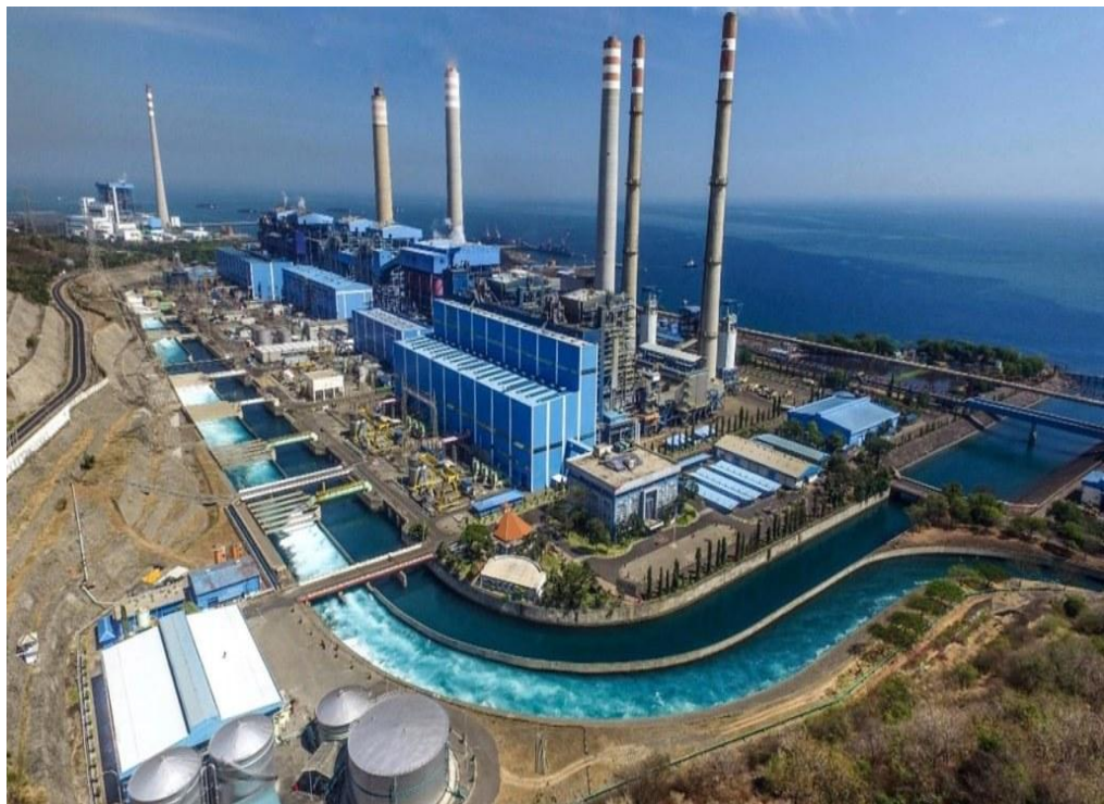
Gambar 2 2 Pembangkit Listrik Tenaga Uap
