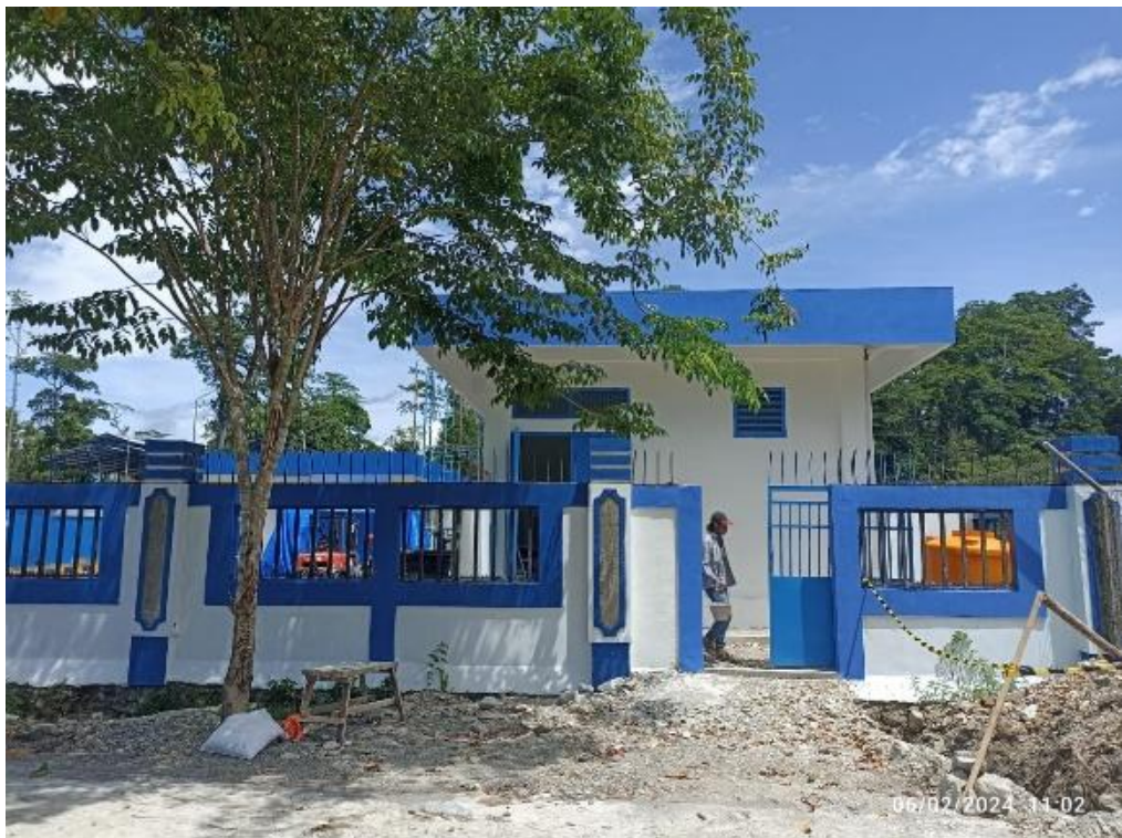
Gambar 2. 7 Tampak Luar Gardu Hubung
