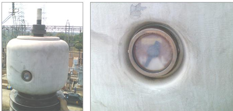
Gambar 2.3.3.3.f. Indikator level minyak bushing
