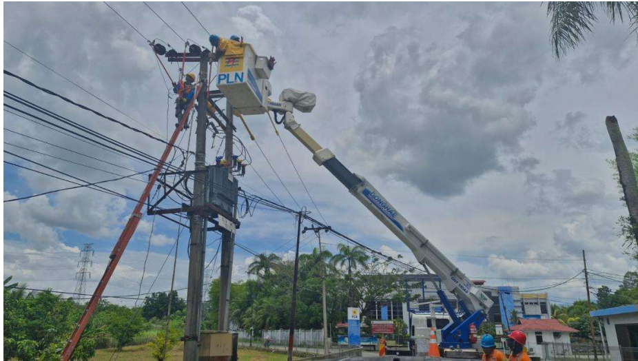
Gambar 2. 10 Pekerjaan dalam keadaan Bertegangan Sumber : Dokumentasi Pribadi
