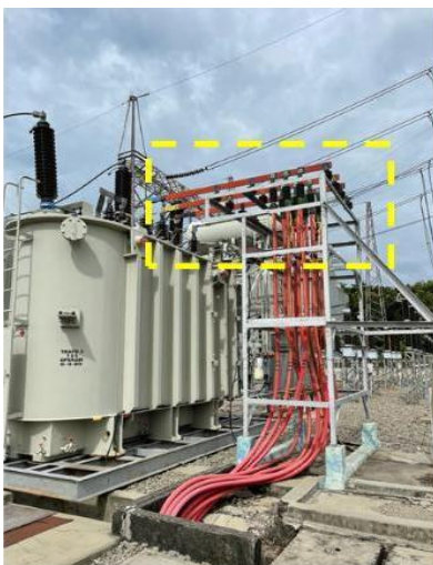
Gambar 2. 9 Trafo daya dengan desain busbar LV terbuka
