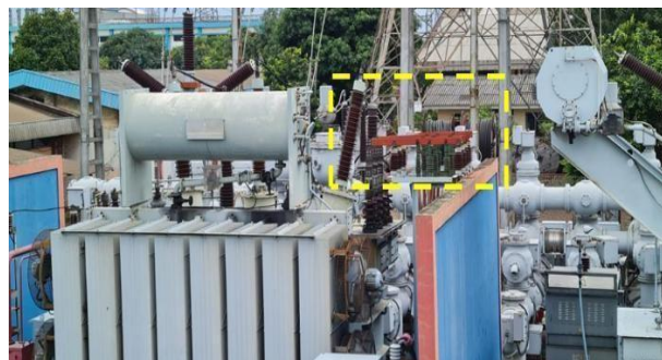
Gambar 2. 9 Trafo daya dengan desain busbar LV terbuka
