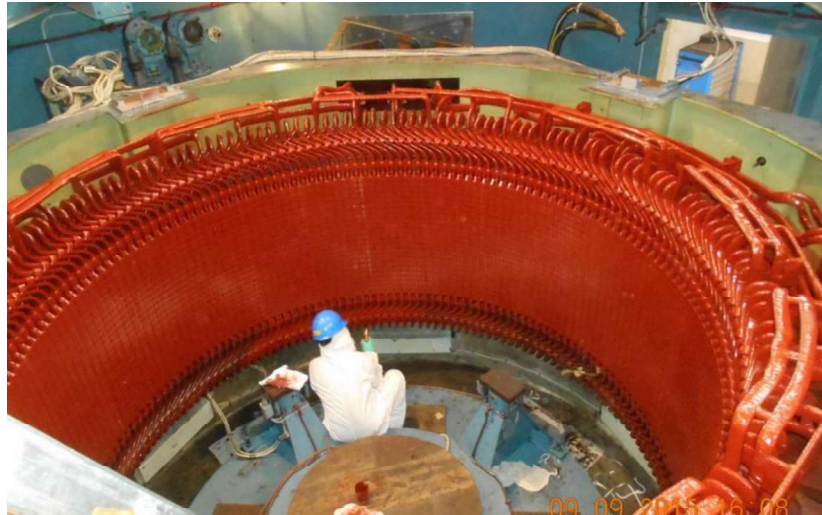
Gambar 2.3 Kumparan tembaga pada stator.
