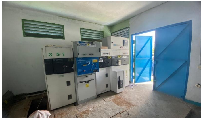
Gambar 2. 3 Komponen Gardu Beton HSTK
