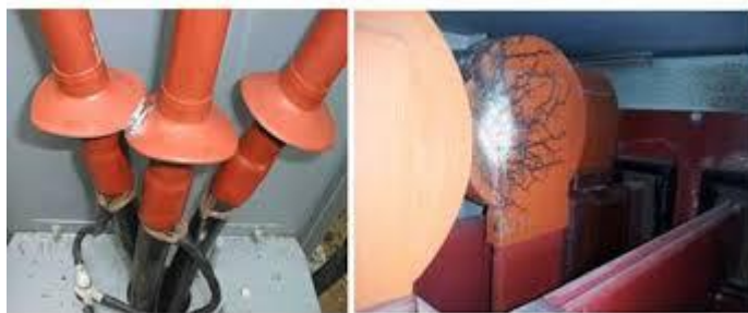
Gambar 2. 7 Korona Pada Kabel
