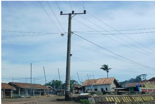
Gambar 2.2 Tiang Beton 12 dAN
