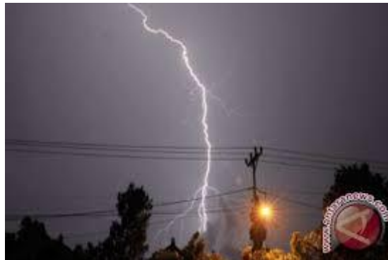
Gambar 2.18 Gangguan Pada SUTM Akibat Petir (Surge Lightning)
