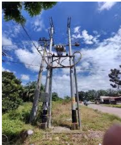
Gambar 2.23 Gangguan Pada SUTM Akibat Mekanis Atau Konstruksi
