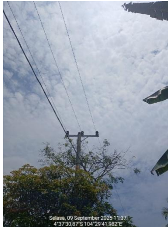
Gambar 3.3 Sebelum Pemasangan Protective Sleeve
