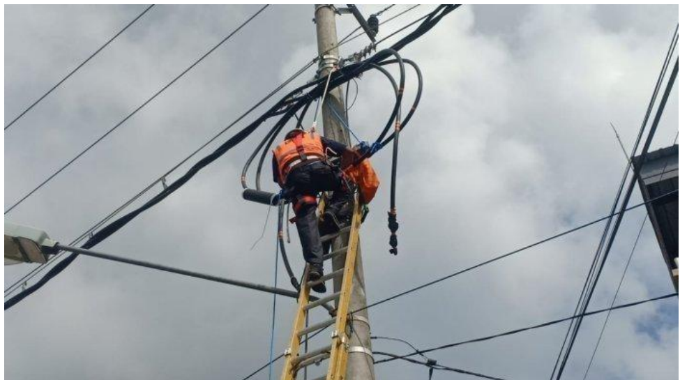
Gambar 2.11 Konstruksi SKUTM
