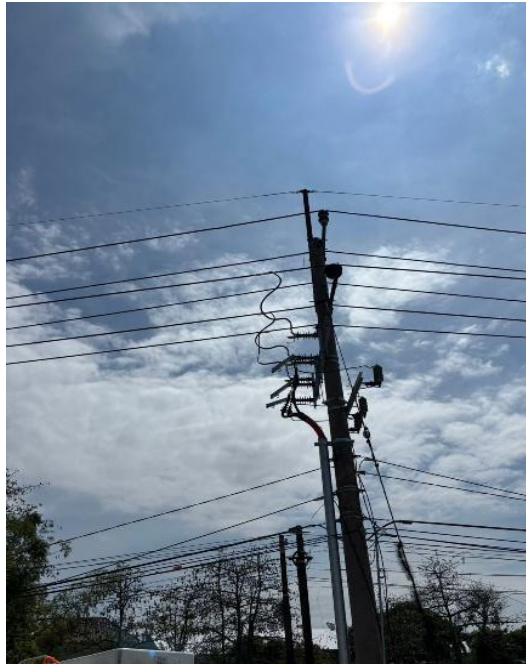
Gambar 2.12 Sambungan SKTM ke JTM
