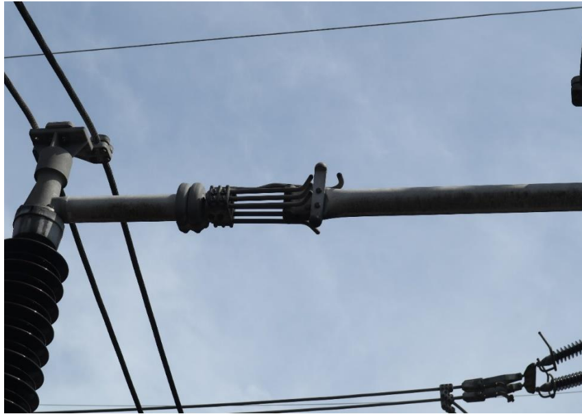
Gambar 2. 16 PMS ABB TIPE SGF170p100+1E Terpasang
