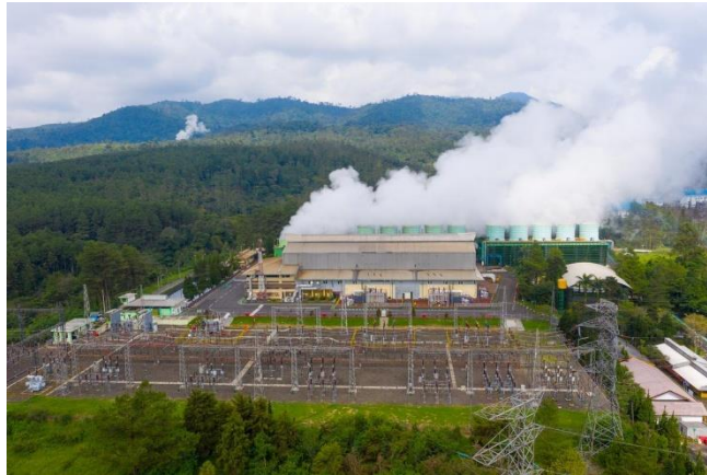
Gambar 2. 2 Pembangkit Tenaga Listrik
