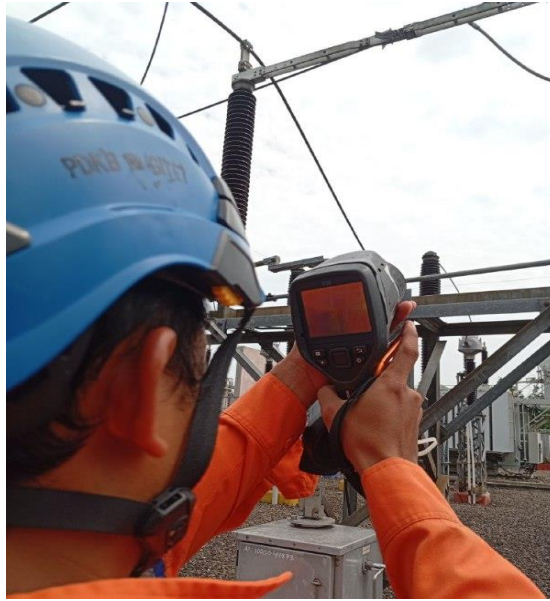
Gambar 2. 13 Proses Monitoring Suhu Menggunakan Thermovisi / Flir
