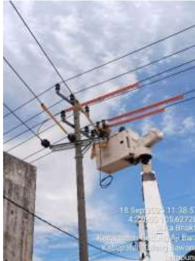
Gambar 2. 3 Pekerjaan Dalam Keadaan Bertegangan (PDKB) TM
