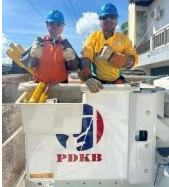
Gambar 2. 5 Penerapan K3 Pekerjaan Dalam Keadaan Bertegangan 20kV
