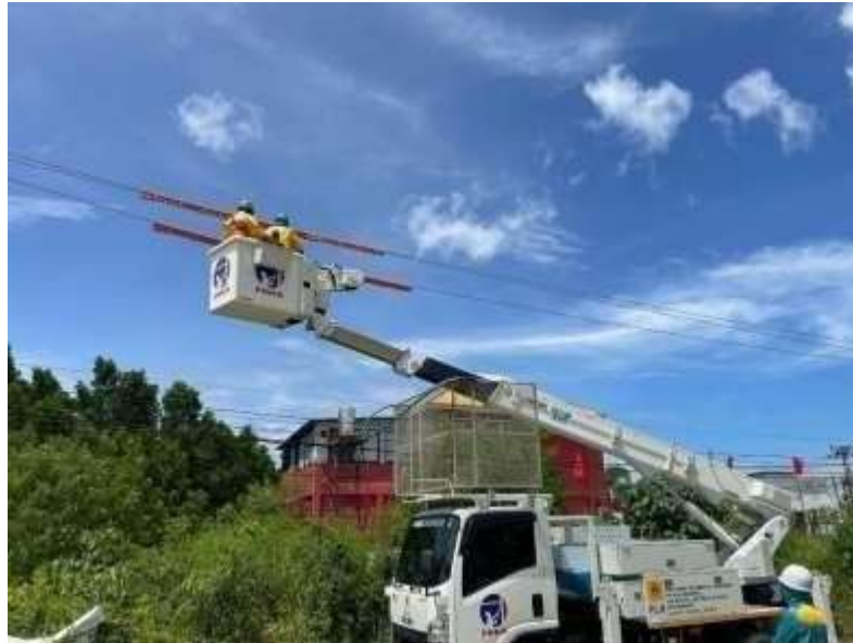
Gambar 2. 4 Metode Sentuh Langsung Pekerjaan dalam keadaan bertegangan 20kV
