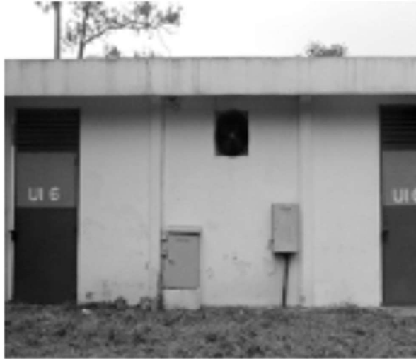
Gambar 2. 2 Gardu Beton , sumber (Buku 4 PLN, 2010)
