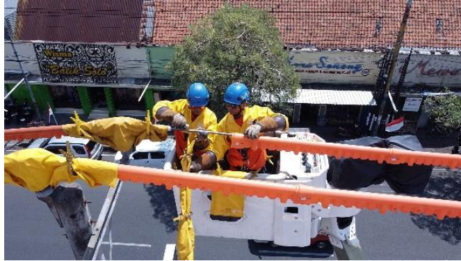
Gambar 2. 3 PDKB TM Methode sentuh langsung
