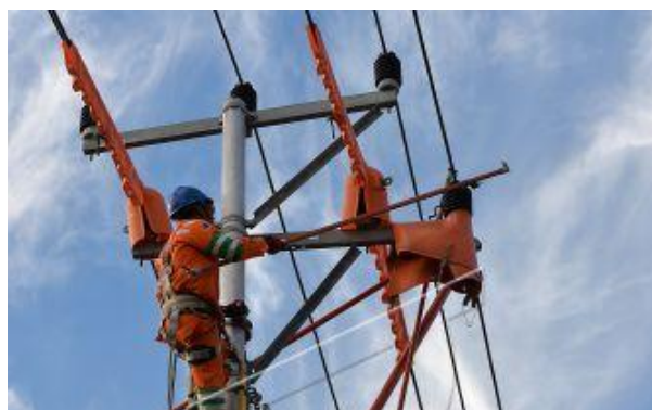
Gambar 2. 2 PDKB TM Methode berjarak
