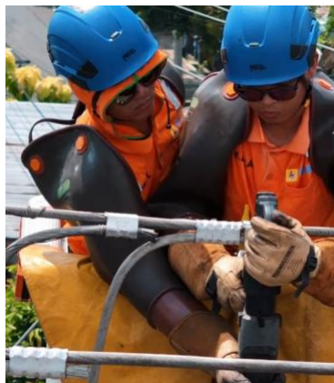
Gambar 2. 6 Proses Press Hydraulic oleh petugas PDKB TM
