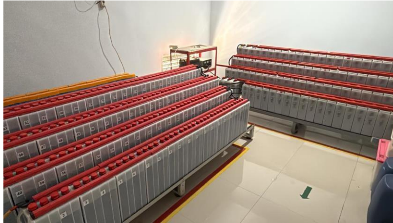
Gambar 2. 2 Baterai 110 VDC GI Soppeng
