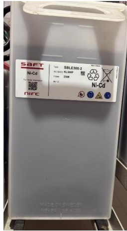
Gambar 2. 4 Baterai 110 VDC
