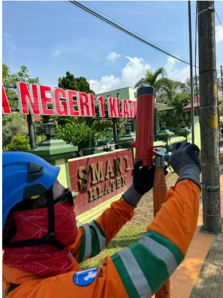
Gambar 2.4 Pemasangan AMPLAS Pada Thelescopic Stick
