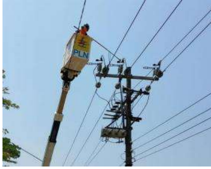
Gambar 3.1 Pelumasan ABSW PDKB-SL
