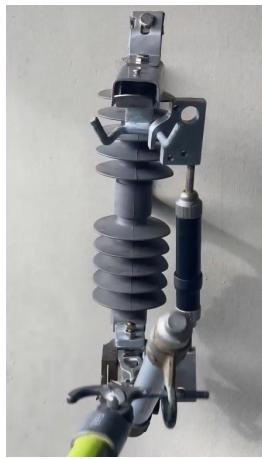
Gambar 3.8. Proses Pemasangan TARING
