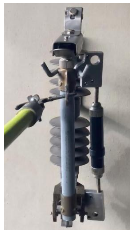
Gambar 3.8. Proses Pemasangan TARING
