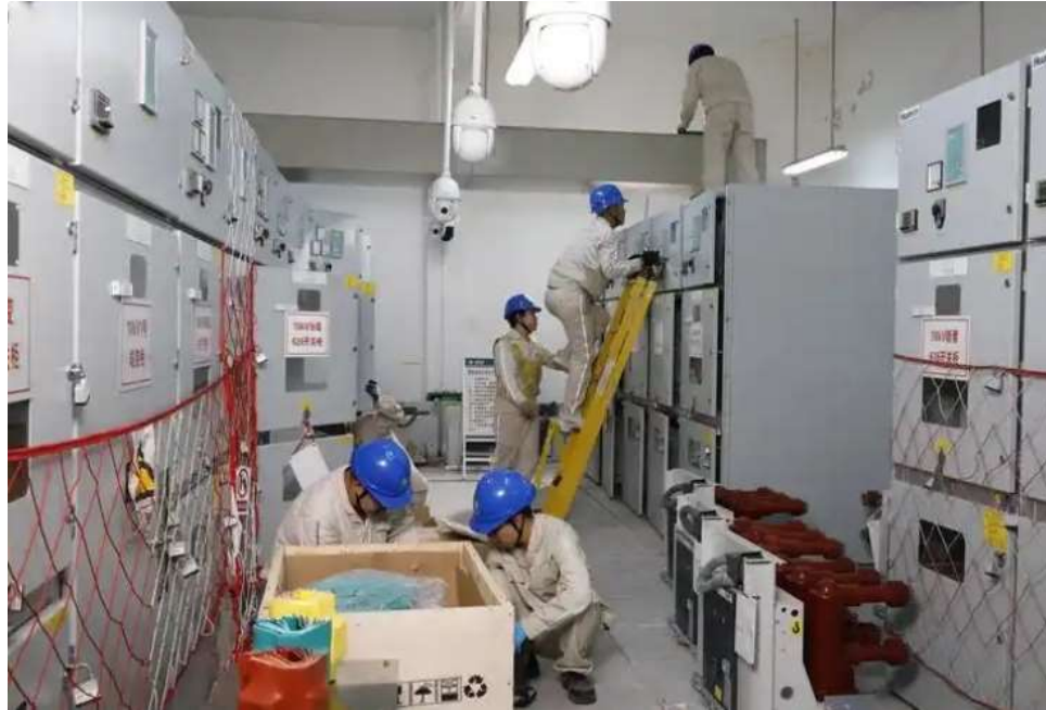
Gambar 2. 16 Pekerjaan Perbaikan Kubikel
