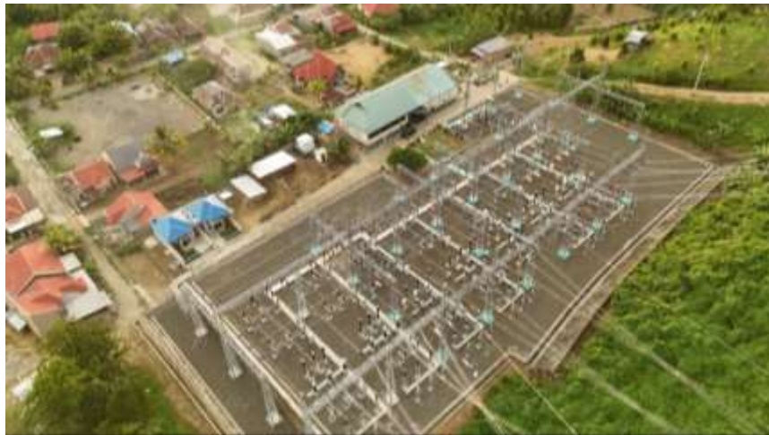
Gambar 2. 2 Gardu Induk Kolaka 150kv
