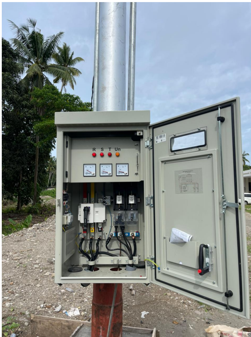
Gambar 2.21 Panel Hubung Bagi Tegangan Rendah Gardu Cantol
