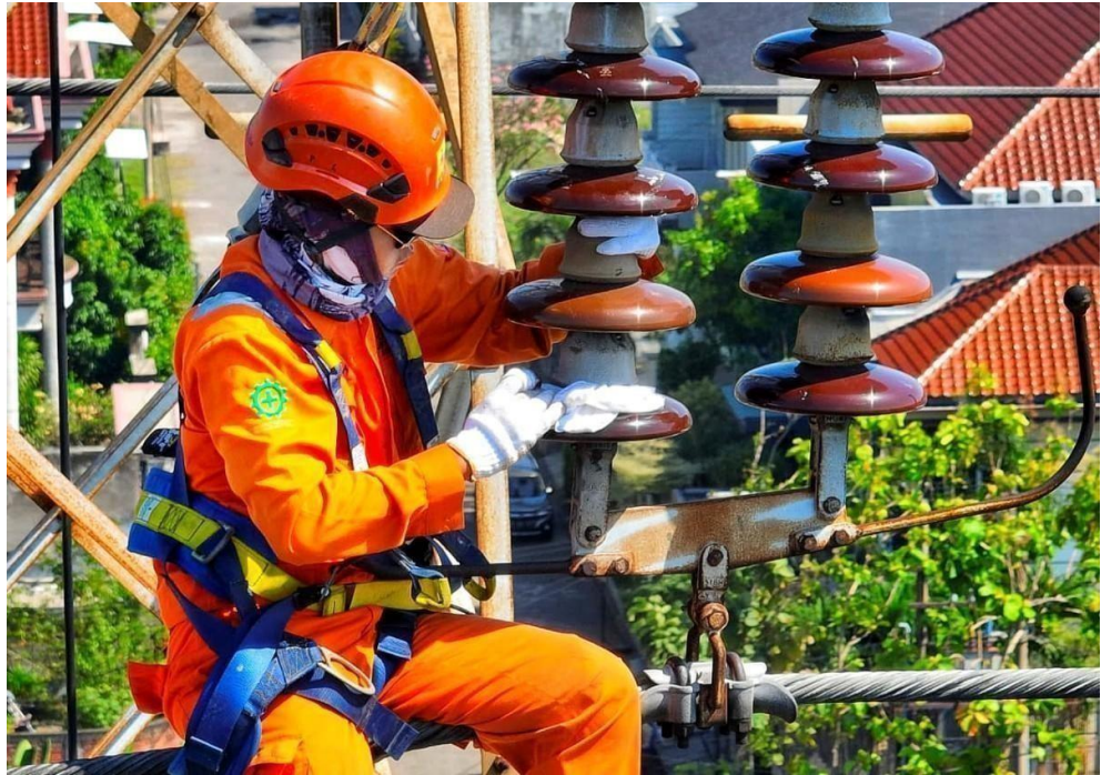
Gambar 2.22 Isolator Gantung Porselin
