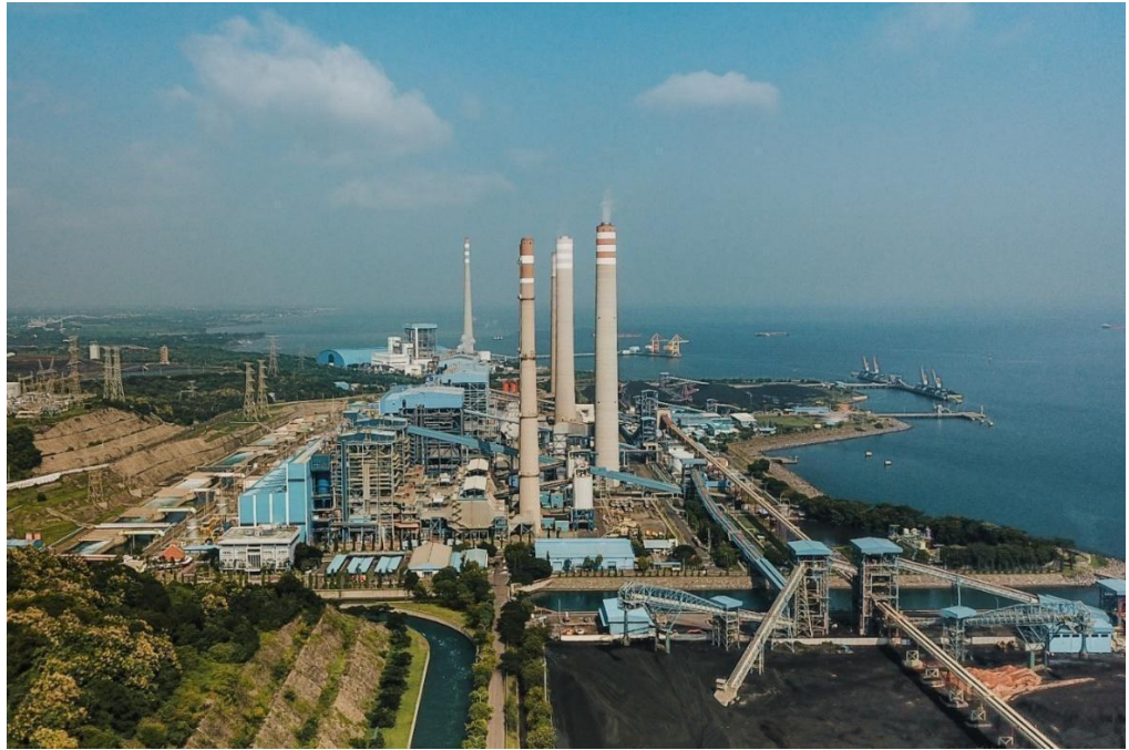
Gambar 2.15 Pembangkit Tenaga Listrik
