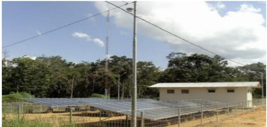
Gambar 2.11 Sistem PLTS Terpusat Off Grid dengan Larik (Array) Fotovoltaik
