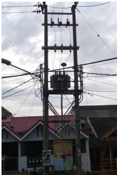
Gambar 2.29 Gardu Portal dan Diagram satu garis Gardu Distribusi
