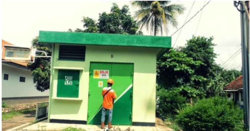
Gambar 2.31 Gardu Beton
