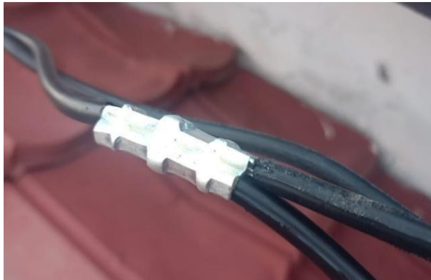
Gambar 2.33 Sambungan Kabel Saluran Rumah
