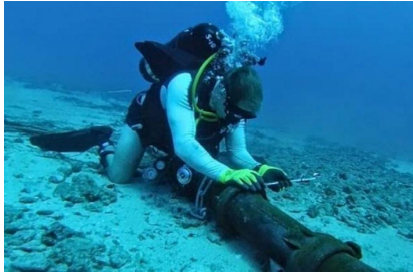
Gambar 2.20 Saluran Kabel Laut Tegangan Tinggi
