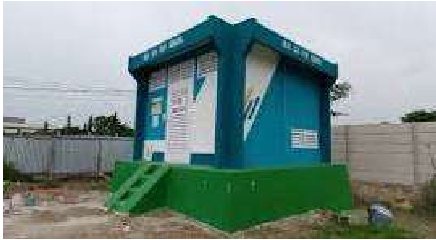
Gambar 2.2 Contoh Bangunan Gardu Beton
