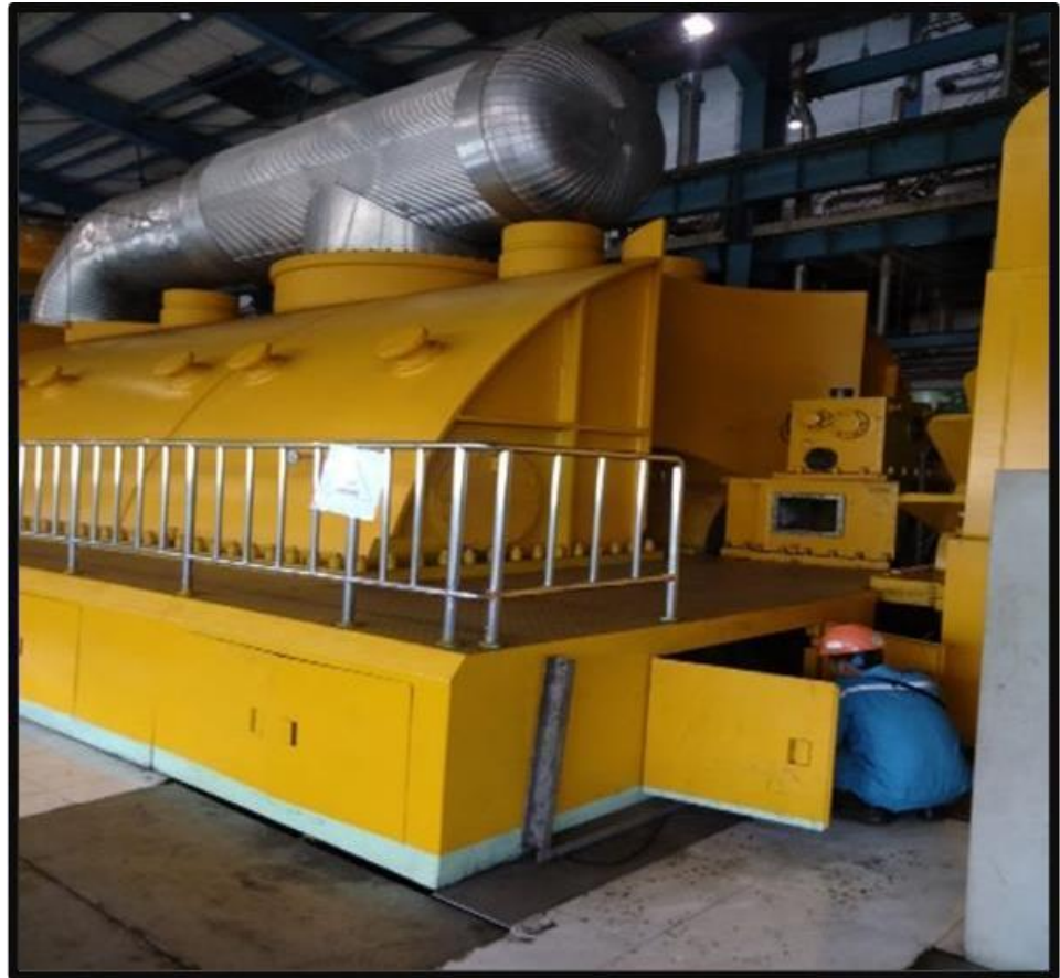
Gambar 2. 5 Turbin Uap (sumber PLTU Banten 3 Lontar, tahun 2025)
