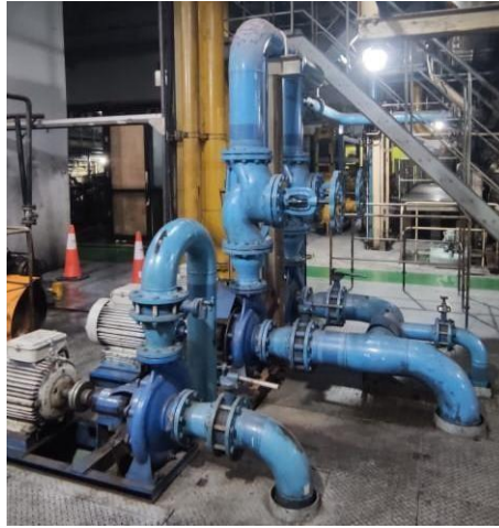
Gambar 2. 4 Sistem Pendingin PLTD Tello
