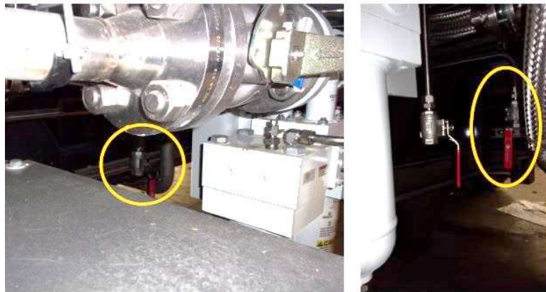
Gambar 2.20 Area Drain Plug setelah di bersihkan
