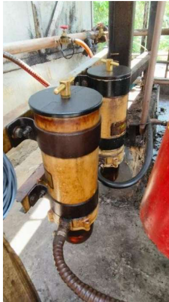
Gambar 2. 5 Filter Minyak Daily Tank ke Unit Pembangkit
