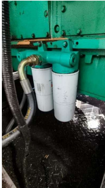
Gambar 2. 6 Filter Minyak di Unit Pembangkit
